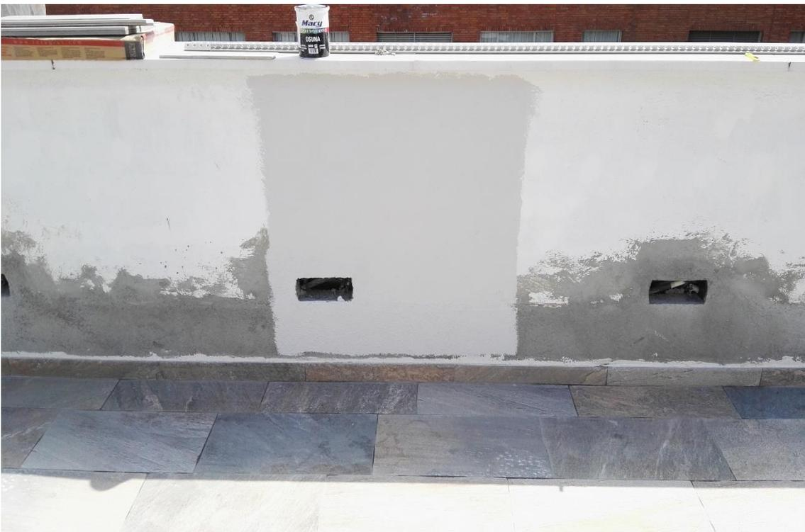
Acabado de las paredes interiores de la terraza pintada con pintura hidrofugante.
