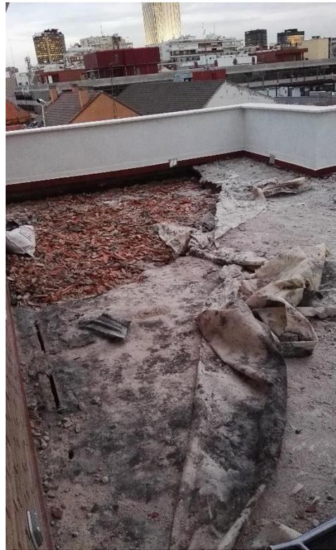
Impermeabilización solado terraza con una doble capa de manta asfáltica.
