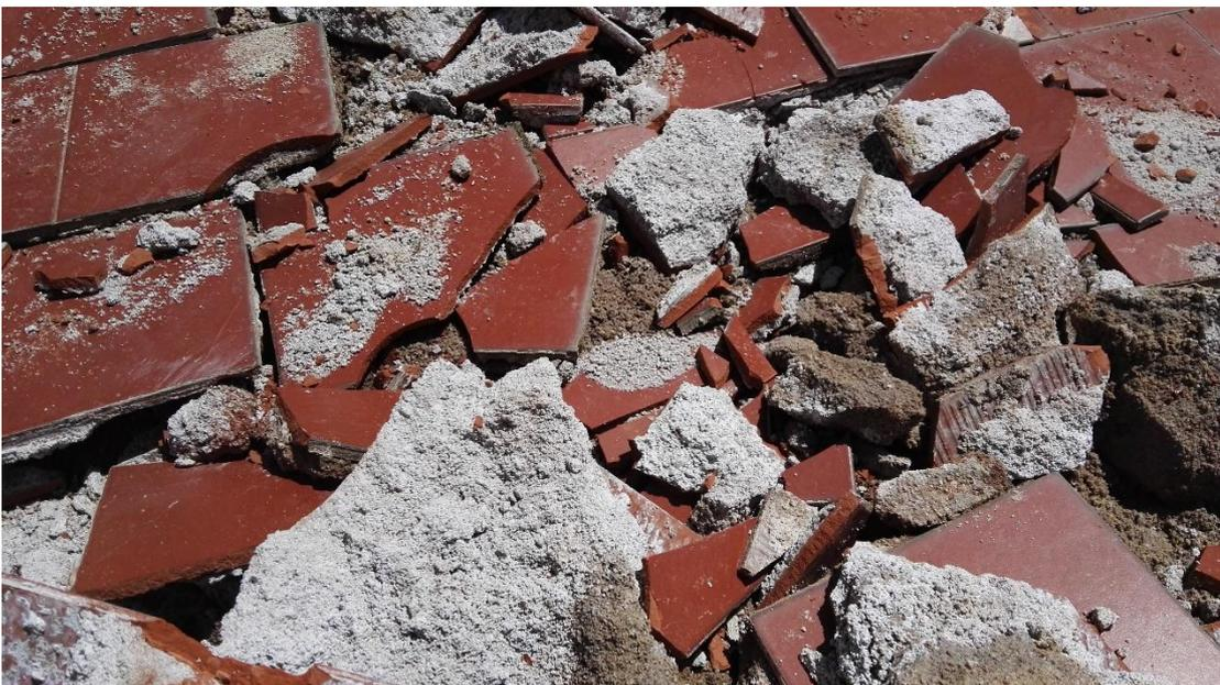
Eliminación de la cámara de aire existente y que está provocando humedades.
