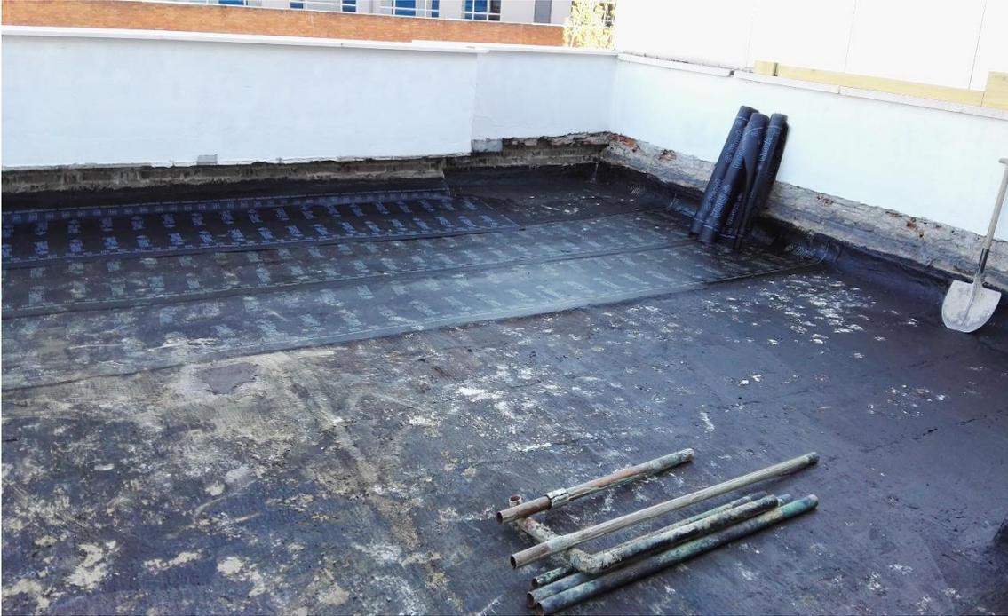
Colocación tela geo-textil para proteger la impermeabiización antes de rellenar e nivelar el suelo de la terraza con arena-cemento.
